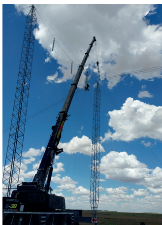
Izaje de cables y mástiles
