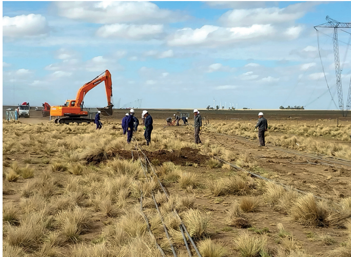
Trabajos en reposición
