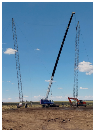
Izaje de cables y mástiles
