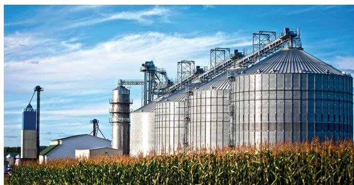
Los silos pueden estar contruidos en hormigón o chapa, y pueden ser verticales o subterráneos. Los silos verticales pueden ser de bases cónicas o planas. En el caso de ser necesario acceder a su interior, se ingresa por la parte superior o bien por compuertas de inspección laterales.
