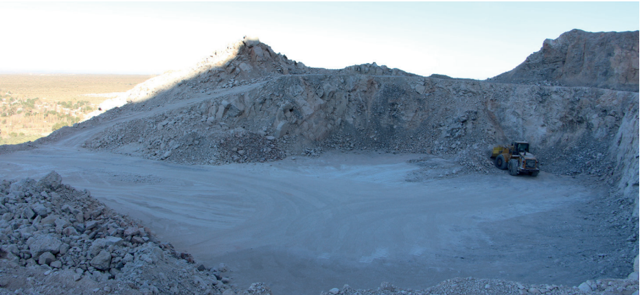
Transporte del material hacia los botaderos
