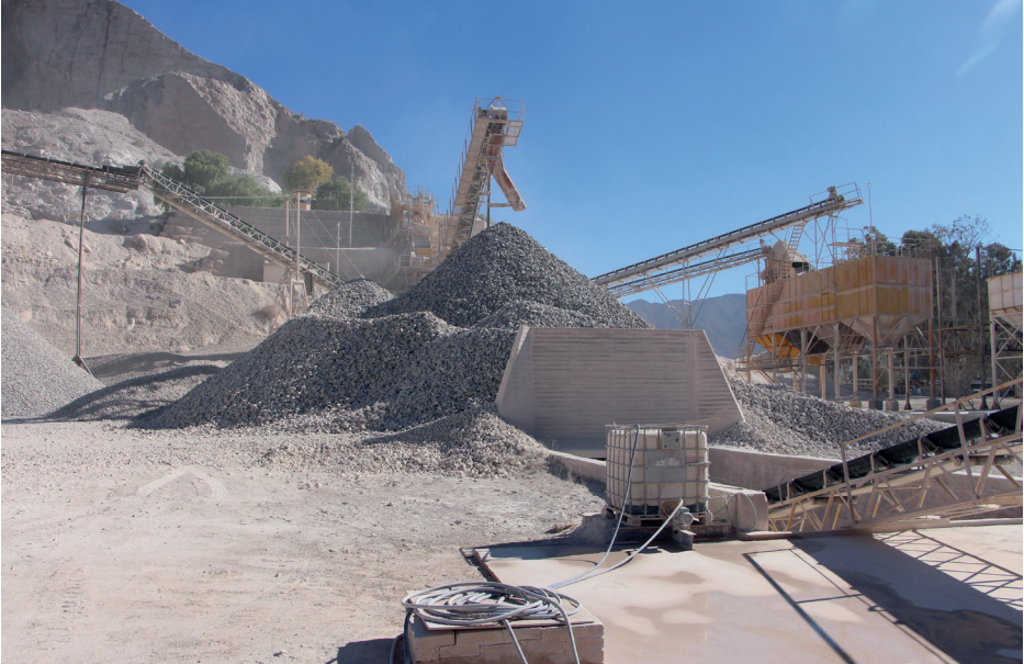
Stockpile de piedra caliza
