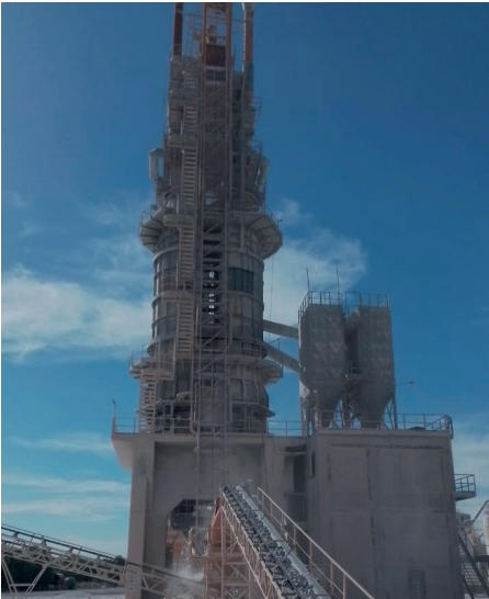
Carga 1: Cinta transportadora con caliza proveniente de la zona de trituración.
