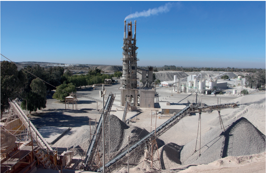
Stockpile de piedra caliza
