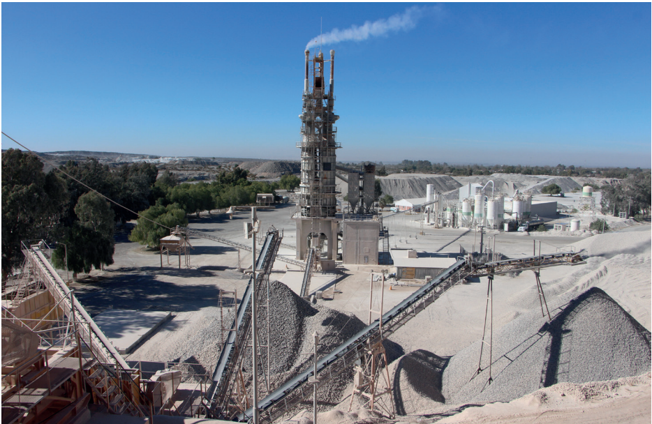
Sistemas de cintas transportadoras y horno de calcinación a gas
