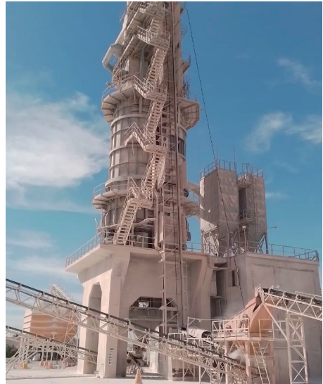
Carga 2: Zaranda para eliminar polvo y finos eventuales y cinta pesadora para alimentar el Skip cargador.
