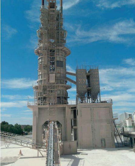
Carga 3: Skip subiendo con la carga de caliza adecuada.
