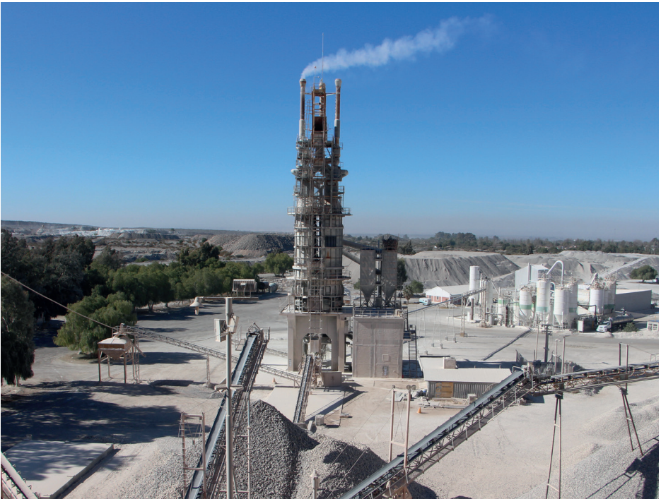
Horno de calcinación a gas
