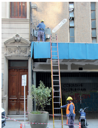
Señalización de la zona de trabajo
