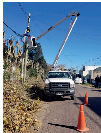
Trabajo con hidroelevador
