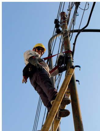
Trabajo en altura
