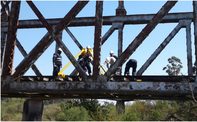
Operarios realizando cambio de durmientes
