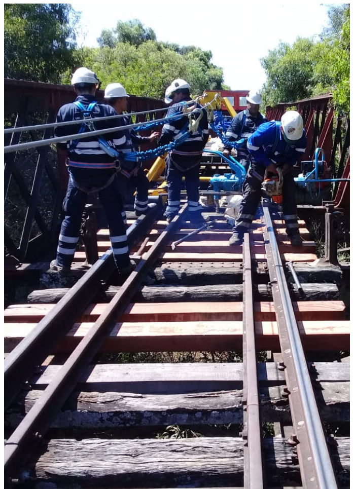
Operarios realizan trabajos en vías utilizando anclajes
