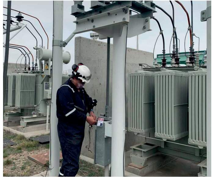
Bloqueo y etiquetado dentro de una ET.
