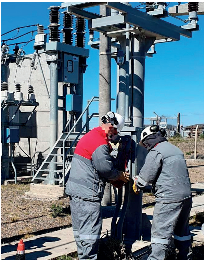
Trabajadores delimitando el área de trabajo y colocando bloqueo y etiquetado.
