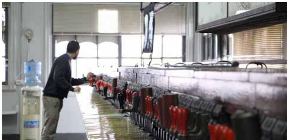
***Cabina electroneumática - Accionamiento de palanca electro neumática.***
