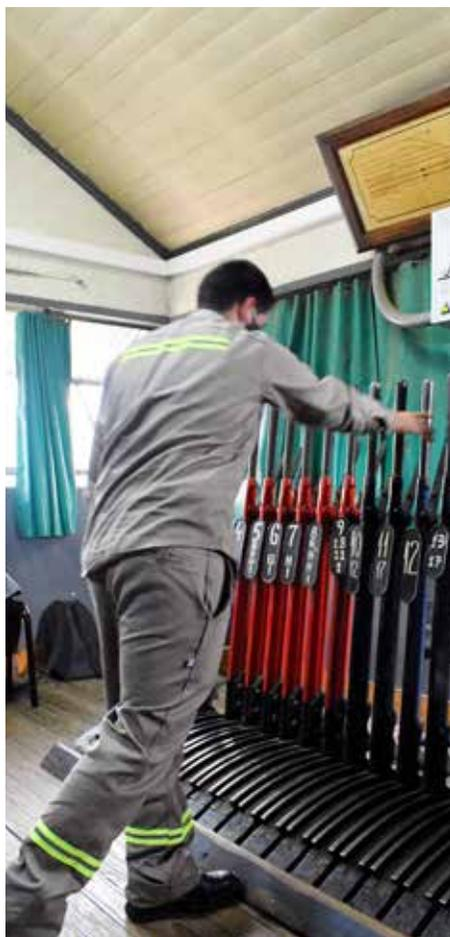
*Accionamiento manual de palancas en una cabina mecánica.*
