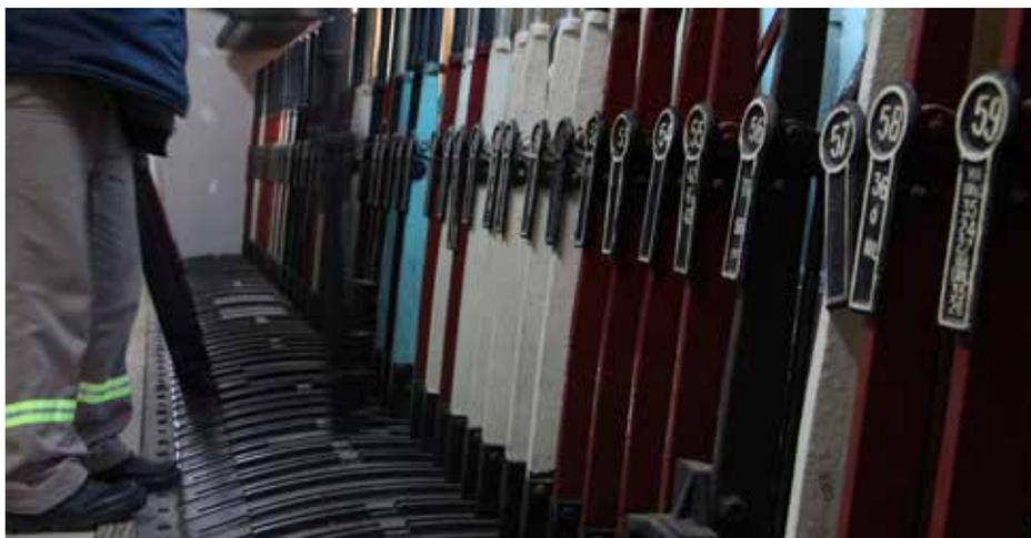
*Posición normal de palancas de accionamiento mecánico.*
