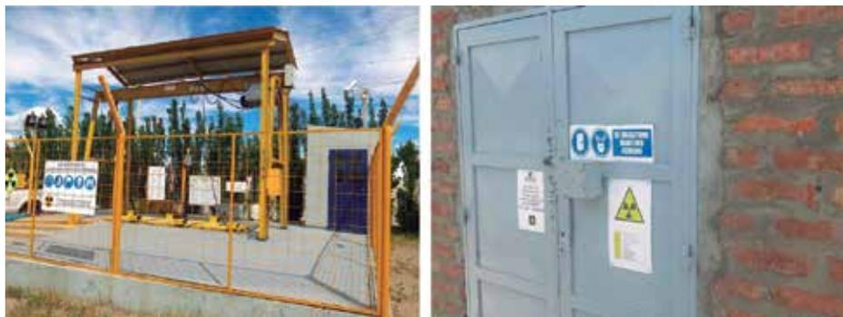
*Vista de dos tipos de bunkers en las que se almacenan fuentes selladas y no selladas, en los que pueden observarse las restricciones perimetrales y la cartelería en la que identifica el riesgo radiológico y la obligatoriedad de uso de los elementos de protección personal.*
