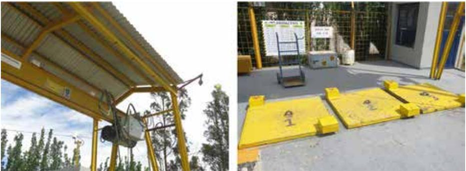
*Dos tomas de un búnker de almacenamiento de fuentes y material radiactivo, donde pueden apreciarse el dosímetro de área y los fosos.*
