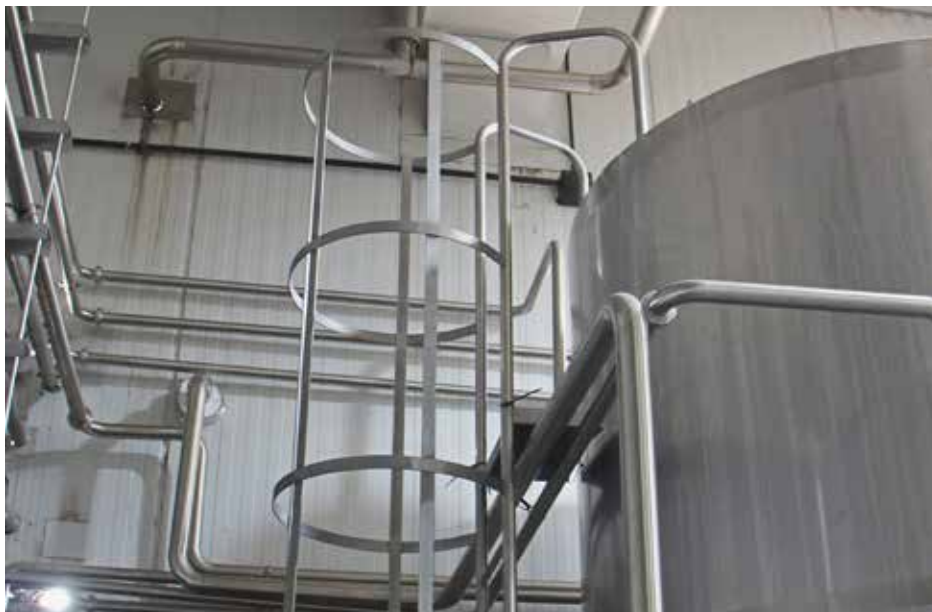
Escaleras de acceso a los tanques.
