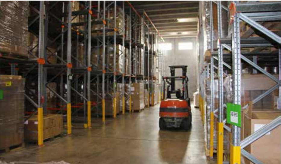
Sector cámara de frío.
