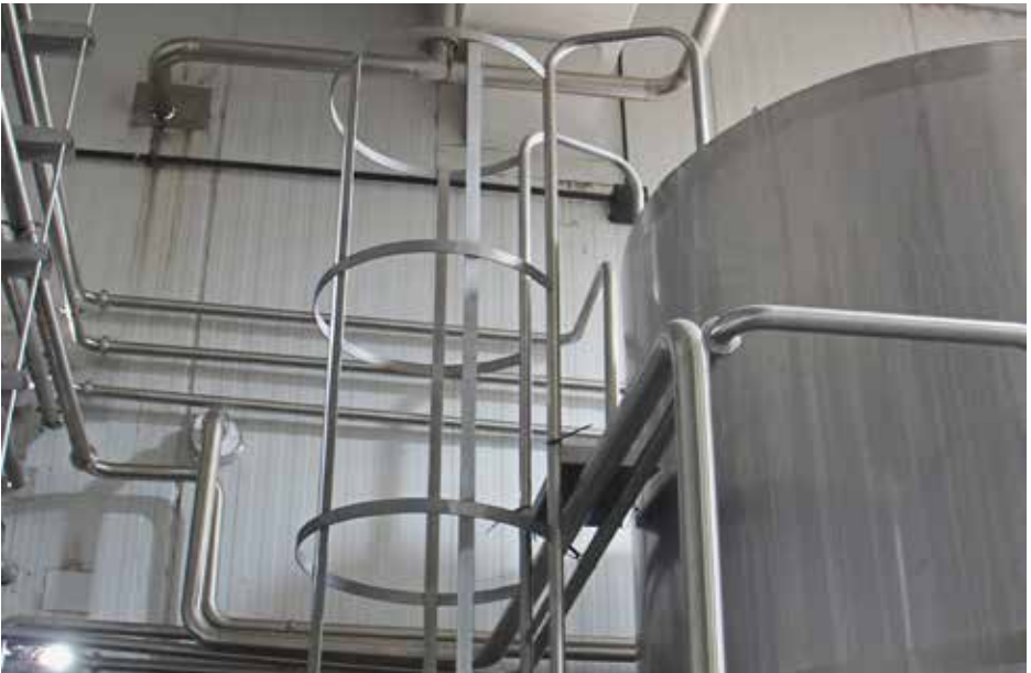
Escaleras de acceso a los tanques.
