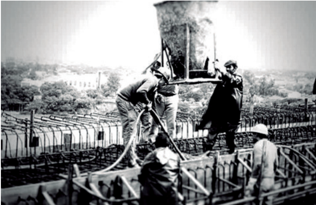
Construcción del puente Gral. Manuel Belgrano (1973).
