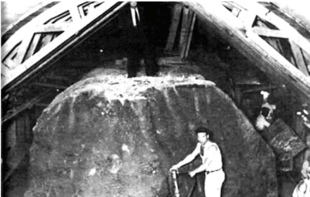
Construcción de la Línea C de subterráneos (1934).
