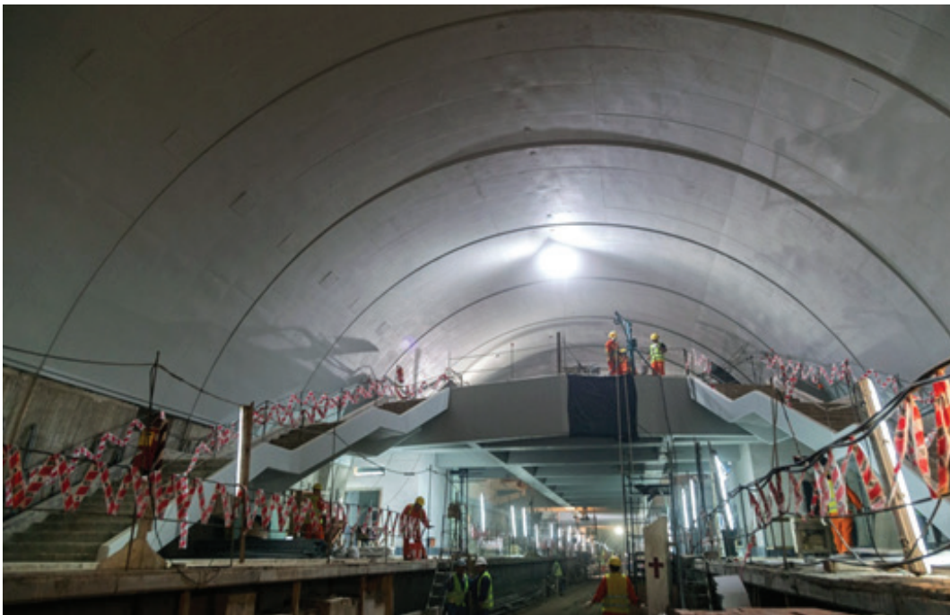
Avances de la obra en la Línea H de subterráneos (2019).
