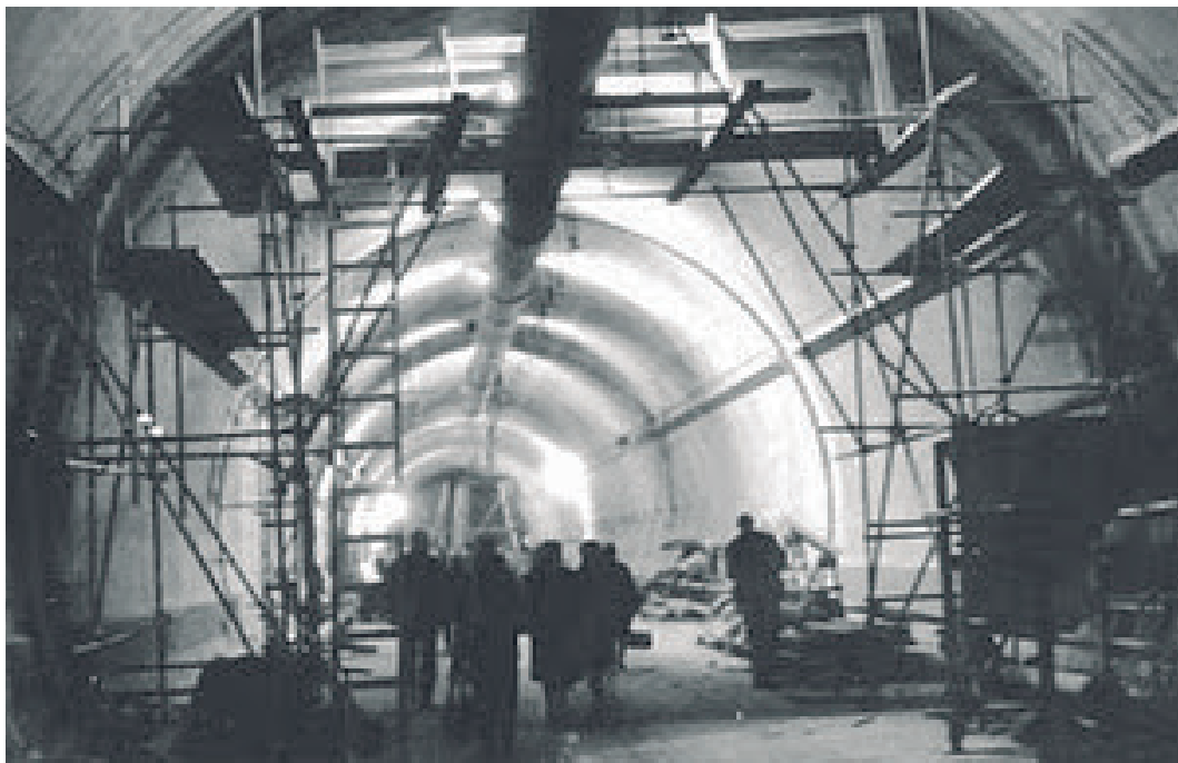
Construcción del Túnel Subfluvial Paraná - Santa Fe (1962-1969).
