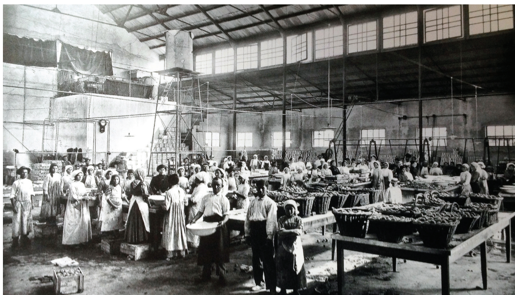
Fábrica de conservas en Mendoza, ca. 1910. Fotografía Archivo General de la Nación.
