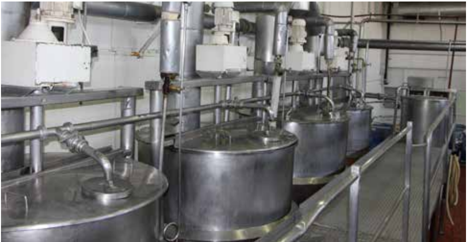
Sector pails, boca de carga. Fuente: SRT (2016)
