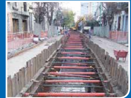
ASÍ SI | Apuntalamiento de excavaciones.
