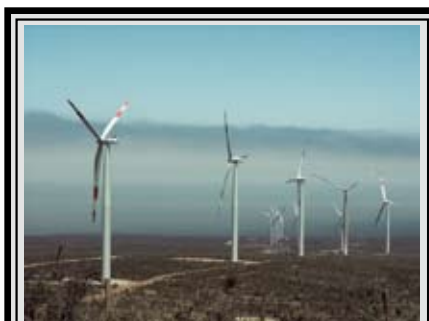
El proyecto del Parque Eólico. ubicado en la zona del Valle de la Puerta, cerca de la localidad de Aimogasta a unos 120 Km. de la Rioja Capital, está orientado a la generación propia de 25 megavatios que son claves para el desarrollo industrial y productivo de la Provincia.
