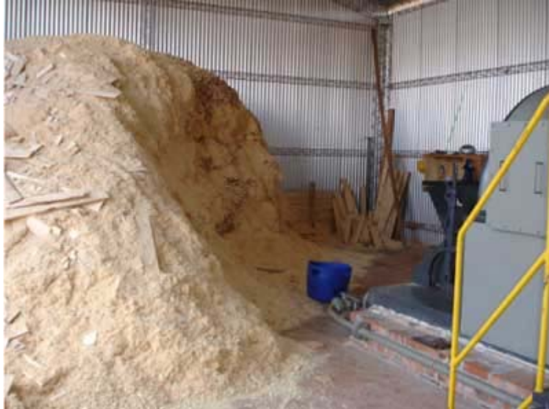
Foto N° 65: Aserrín que se utiliza como combustible para la caldera
