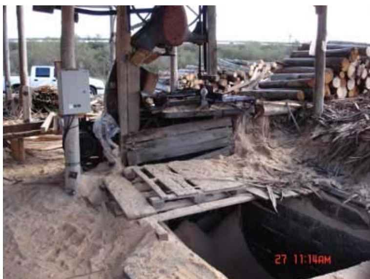
Foto N° 51: Fosa de sierra sin fin carente de protección para evitar caídas
