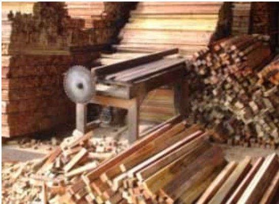
Foto N° 42: Sierra circular sin protecciones
