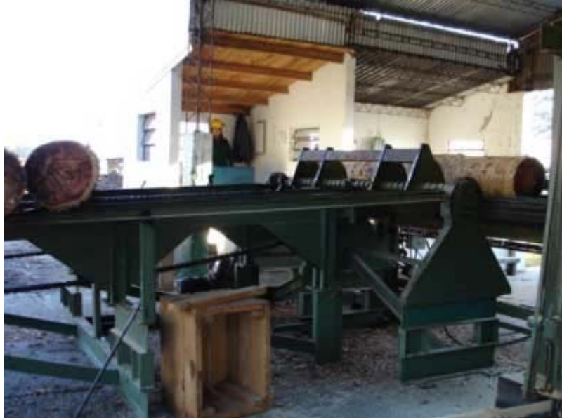
Foto N° 28: Puesto de comando y entrada de troncos en sierra principal
