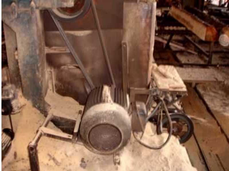
Foto N° 52: Acumulación de aserrín
