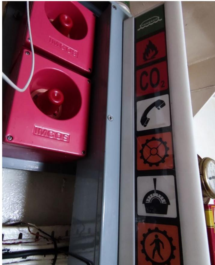
**Figura 2: Ejemplo de señalización de la alarma de CO<sub>2</sub> en un buque pesquero dentro de una columna de indicadores.**
