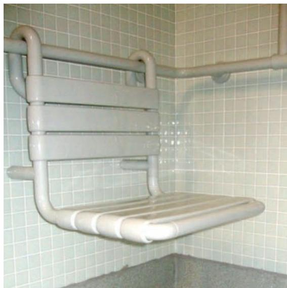
*Figura 11. Silla acoplada en barra (2).*
