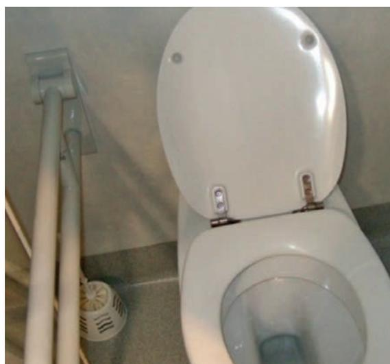
Figura 3. Barra de sujeción lateral.
