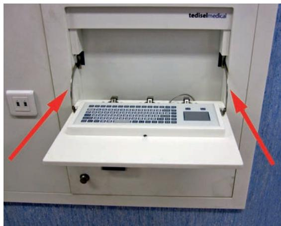
Figura 10. Teclado con piezas de sujeción.
