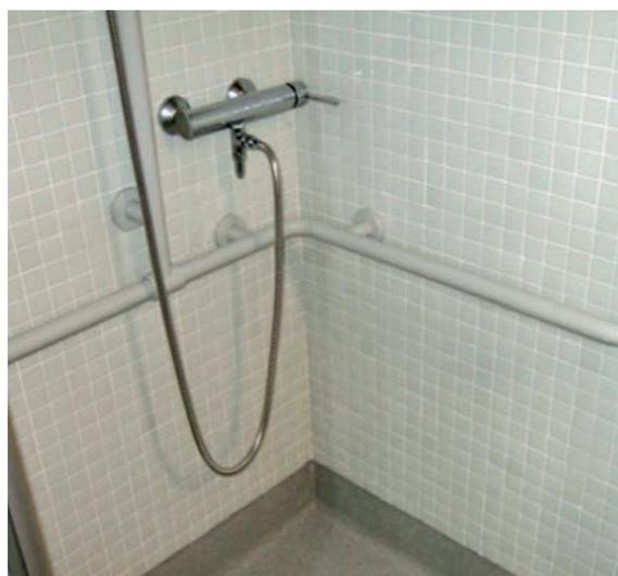
*Figura 9. Barra de ducha para colocar la silla.*
