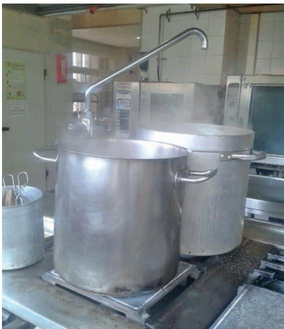
*Figura 5. Grifo en los fogones para el llenado de las ollas.*
