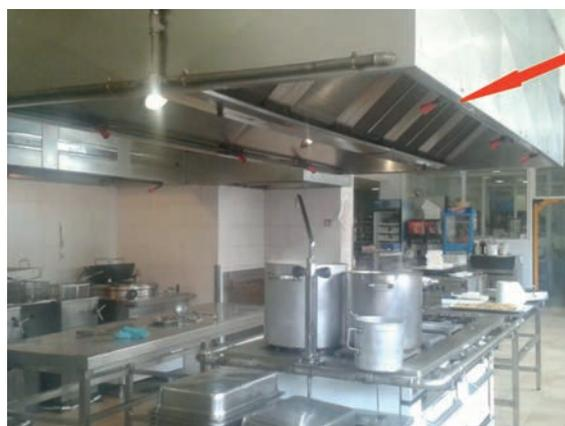
*Figuras 9 y 10. Campana con el sistema de extinción colocado en el borde interno.*
