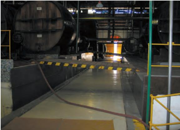
**Figura 19:** Al instalar un puente para cubrir una rejilla o un desnivel entre dos sectores próximos, asegúrese que la superficie de la placa sea plana, no resbaladiza y que permita el rodamiento suave de las ruedas.
