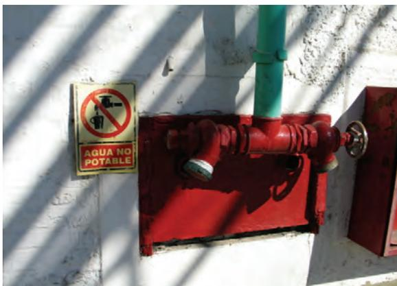
Figura 23: Toma de agua y mangueras para la lucha contra incendios. Deben estar correctamente señalizadas y en perfecto estado de conservación y funcionamiento.
