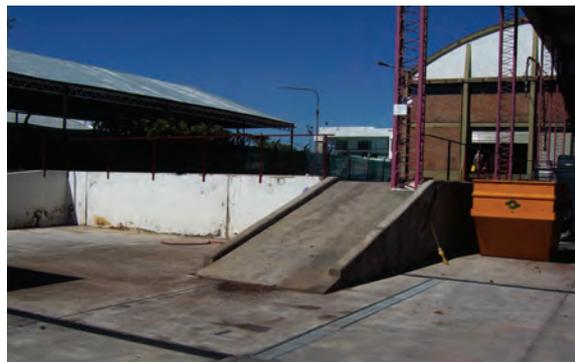
Figura 7. El alcantarillado que se observa en el piso facilita el lavado de la zona sucia para la descarga de uva de la zona limpia necesaria por reglamentaciones de higiene.
