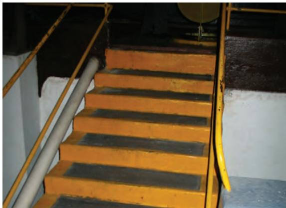
**Figura 18:** En las escaleras instale barandas y en los peldaños coloque bandas o cintas rugosas que eviten resbalamientos.
