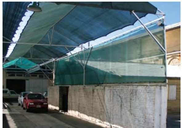
Figura 5: Una solución de bajo costo para proteger vehículos y mercaderías consiste en colocar materiales sintéticos (media sombra) como aislante del calor exterior.
