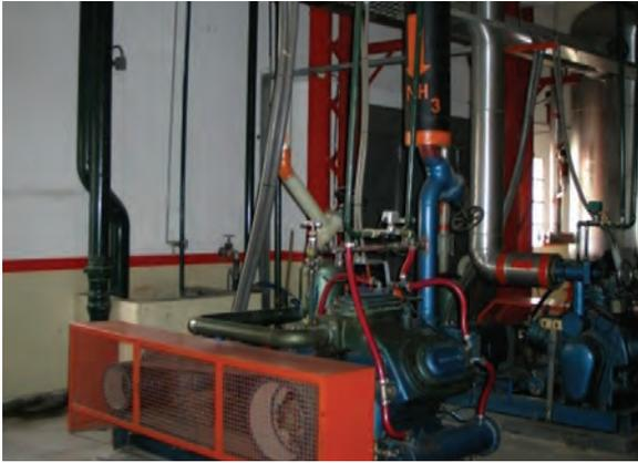
**Figura 9:** Equipo provisto de protección realizado con un bastidor sólido con malla metálica de fábrica que facilita el control visual del estado de las correas.
