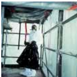
Enclaustramiento sobre andamio.
