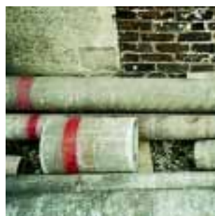
Canalizaciones de fibro-cemento.
