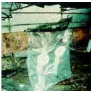
Bolsa con mangas sobre una canalización.
