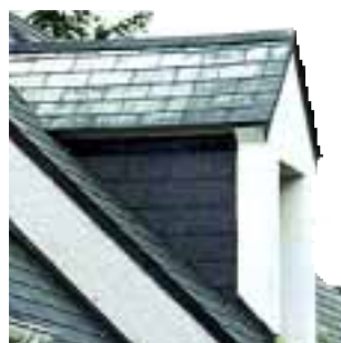
Tejado de fibro-cemento.
