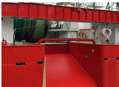
Figura 21. Estructura con forma de U invertida en la zona de rampa.
