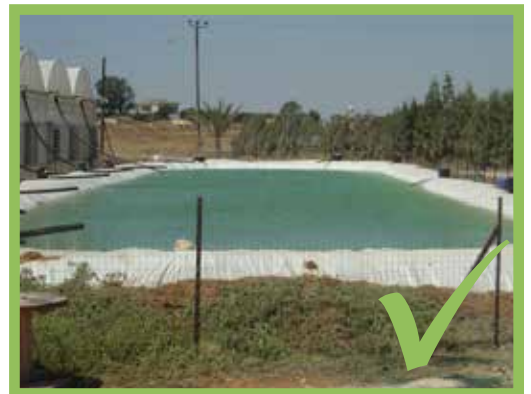
Valle las balsas, los depósitos de agua, las zanjas y las fosas o evite mediante un dispositivo adecuado el acceso a ellos.
