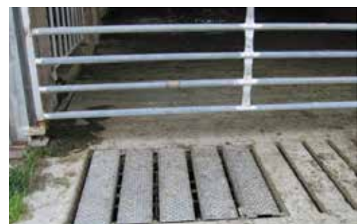
Al final de la tarea, vuelva a colocar las cubiertas.
