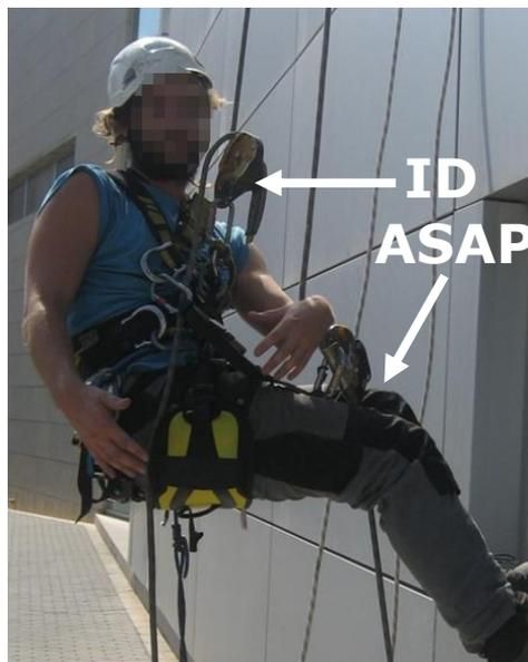
Figura 6. Esquema del ID y ASAP.
