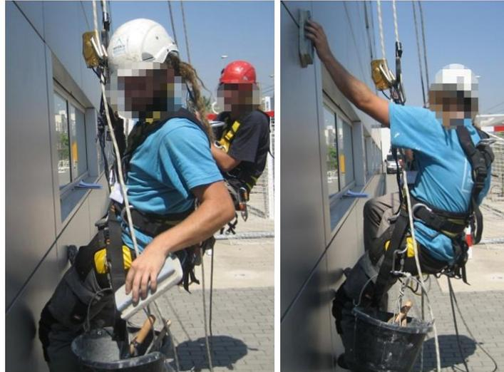
Figura 8. a) Posición natural de reposo b) Posición de trabajo.
