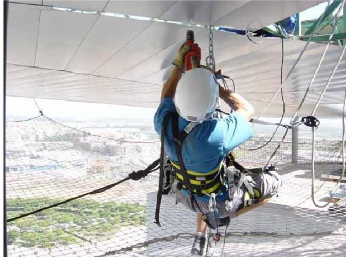
Figura 1. Ejemplo de postura forzada en trabajos verticales. *Imagen cedida por Vértice Vertical S.L.*
