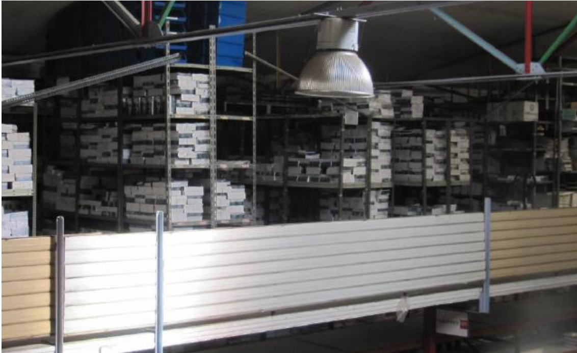
Atillo en el que se ha dispuesto una barandilla cuajada
