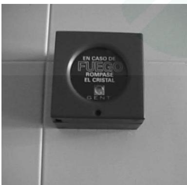
La alarma consiste en avisar de forma que se ponga en marcha la evacuación de las personas y la extinción del incendio. La alarma manual se puede realizar mediante unos pulsadores debidamente localizados y accionados por personas. También se puede dar la alarma por otros sistemas (megafonía, etc.) o bien ésta puede ser automática pasando por una central de control desde la que se darán las órdenes oportunas para ejecutar el Plan de Evacuación.
